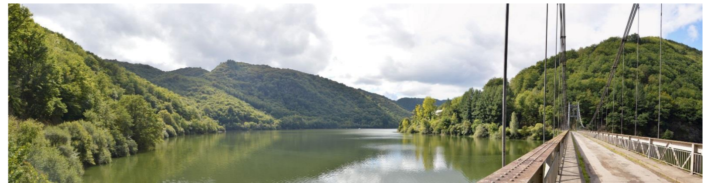
Photographie 7 : Traversée des gorges au Pont de Chambon.
